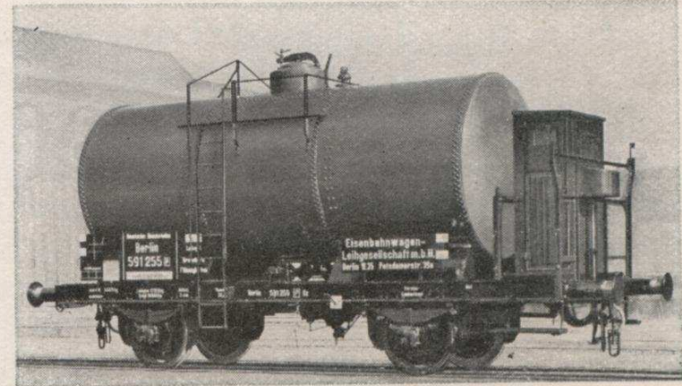
Abb. 26 Kesselwagen für Transport von Benzin usw. mit Bremserhaus. Vorbild des MARKLIN -Miniaturwagens 314
